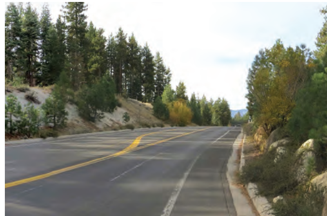
Foto: pista actual de Lake Parkway
